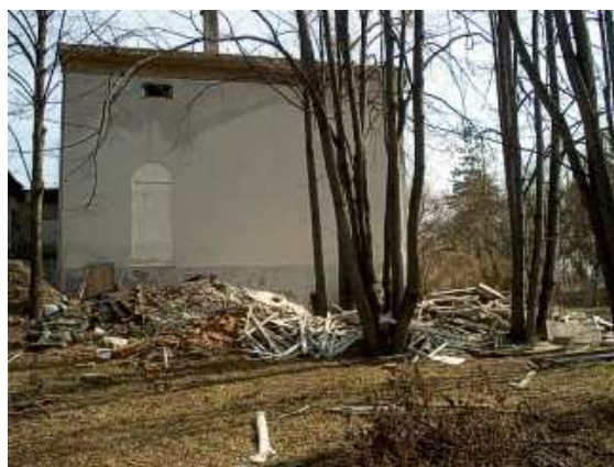
Posesja prywatna w trakcie remontu, ul. Okrzei
