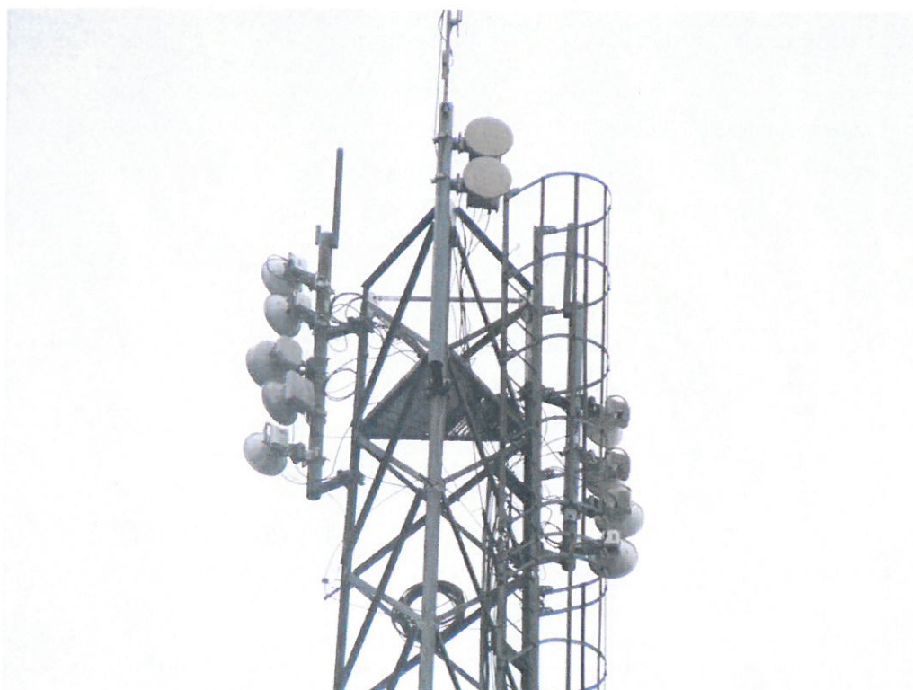
Widok instalacji radiokomunikacyjnej Stacja Netia LEGAB014 - LEGAM00003 Legnica, ul. Ścinawska 1b.
