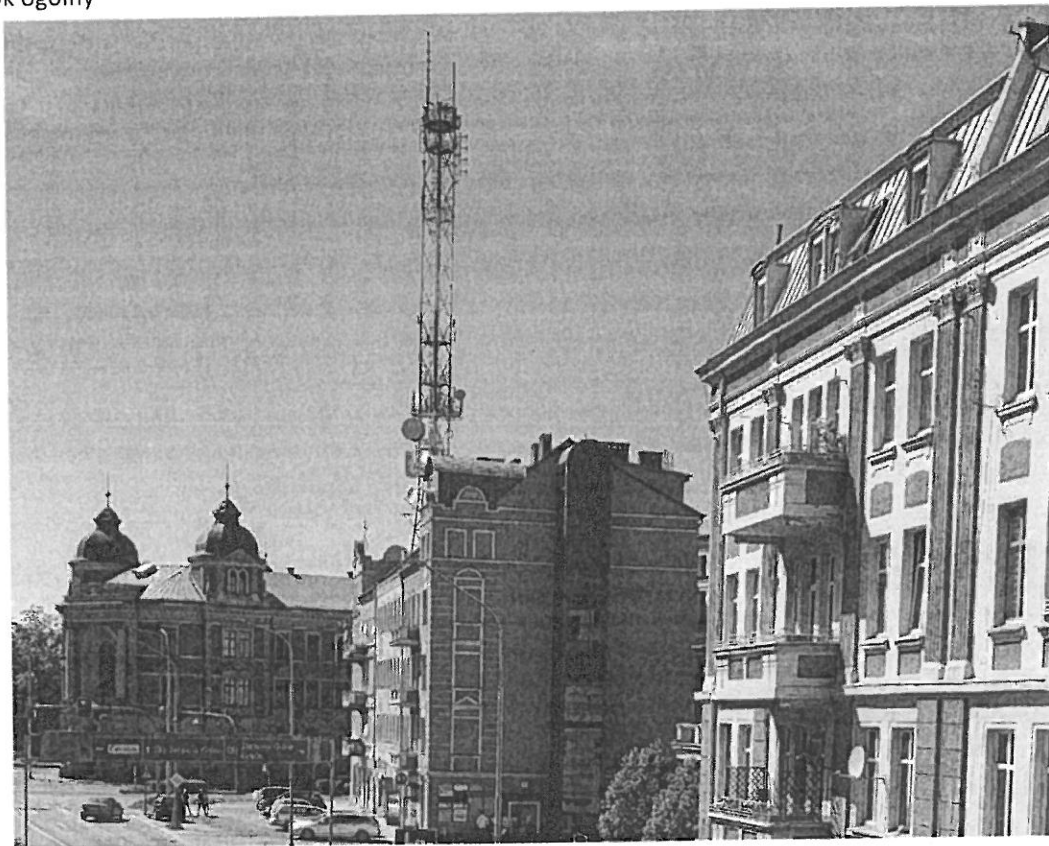
Zdjęcie 1 Badany obiekt
