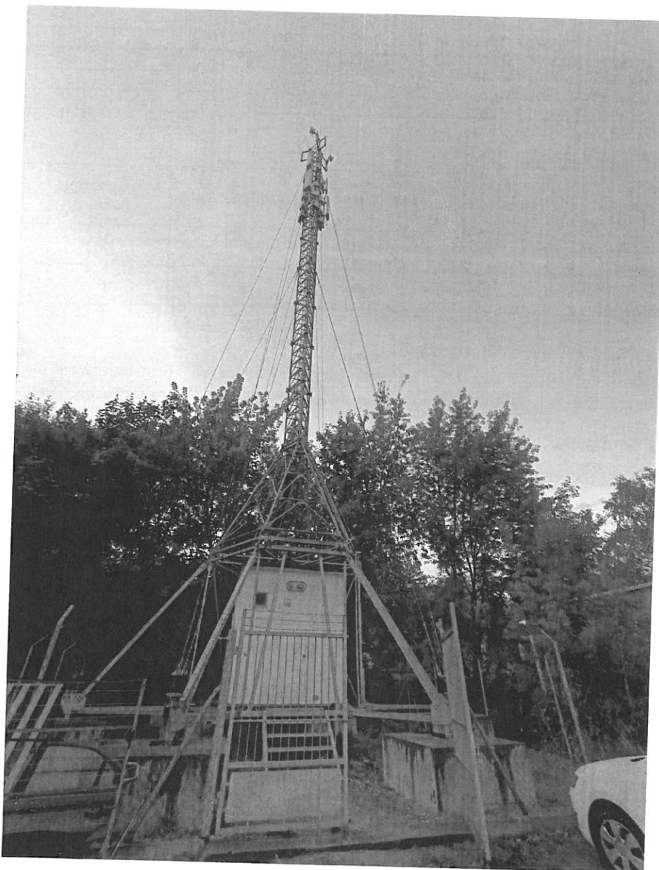
Zdjęcie 1 Badany obiekt
