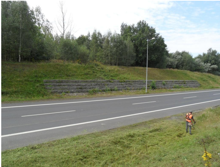
Zabezpieczone osuwisko na skarpie południowo-zachodniej wykopu ulicy Zachodniej
