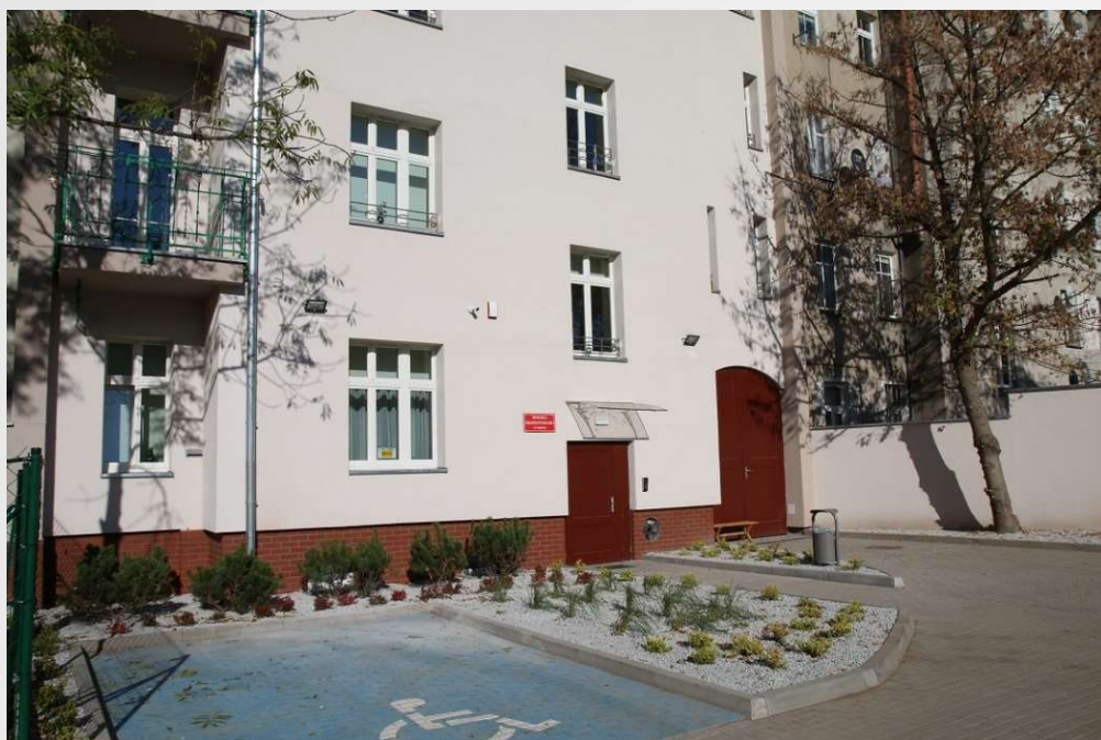
Budynek Centrum Integracji Społecznej
