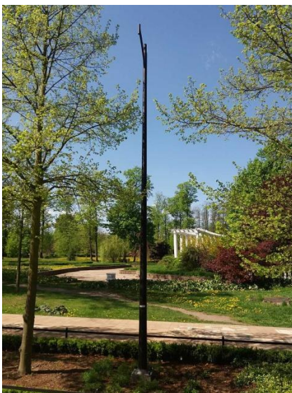
Istniejące słupy dedykowane do kamer monitoringu miejskiego.
