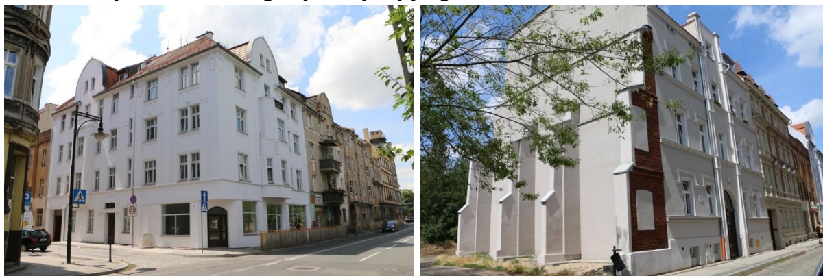
Kamienice przy ul. H. Pobożnego
