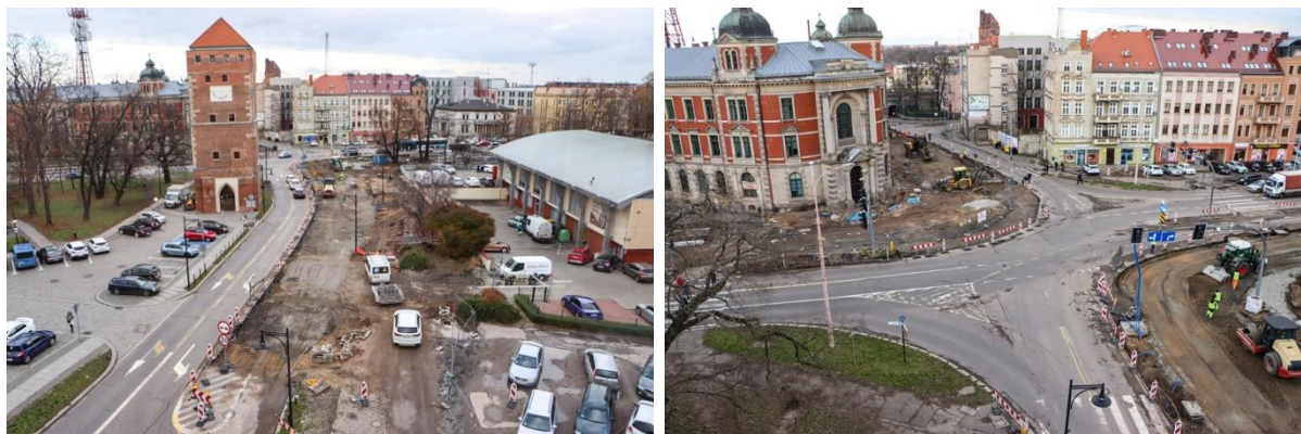
Przebudowa ul. Pocztowej i ul. Piastowskiej
