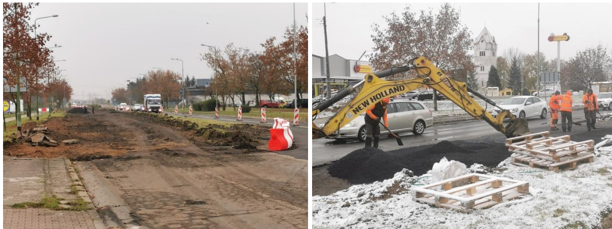
Przebudowa ul. Sikorskiego
