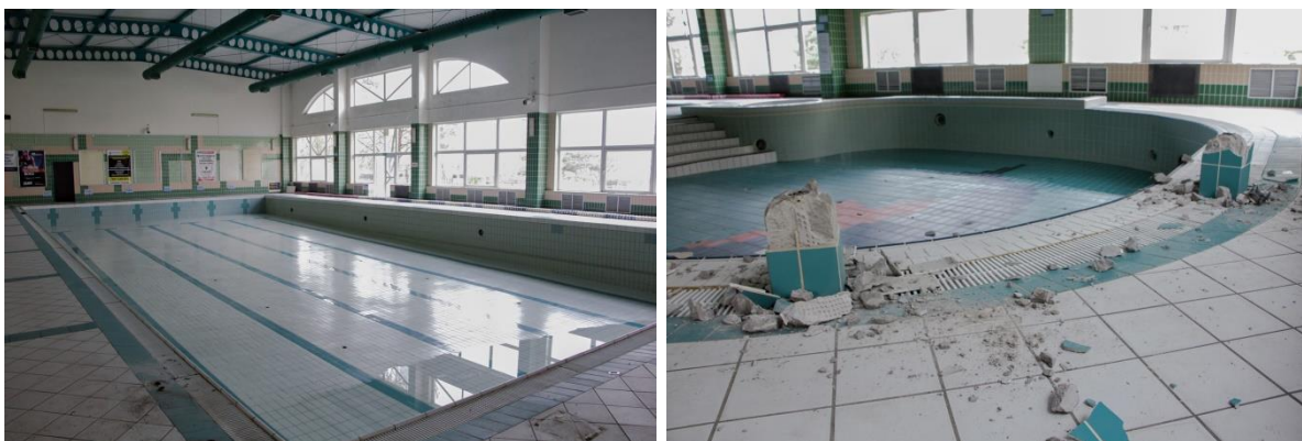
Przebudowa basenu „Bąbelek”
