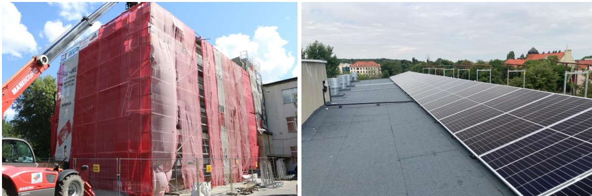
Przebudowa Zespołu Szkół Budowlanych
