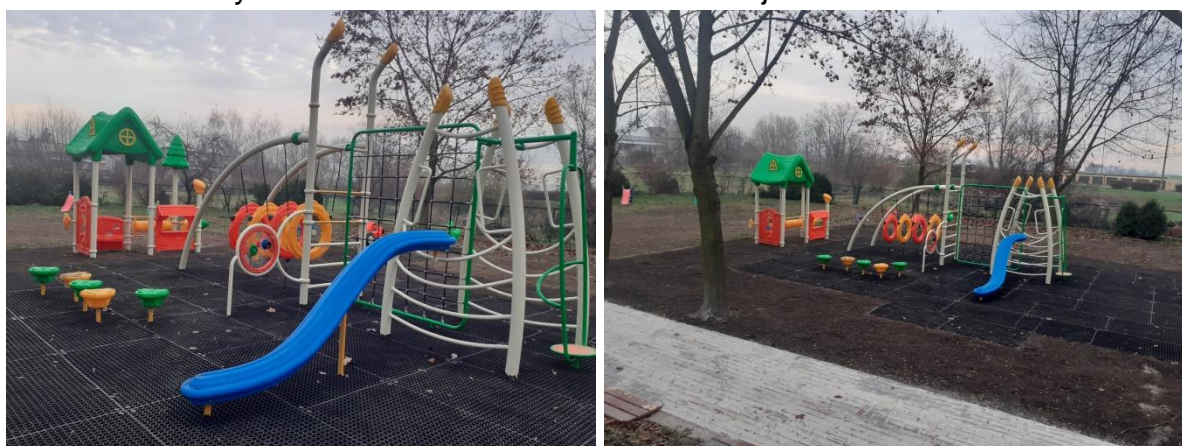
Przebudowany placu zabaw przy ul. Tatrzańskiej
