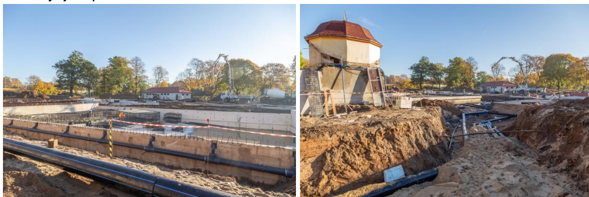
Przebudowa basenów przy ul. Stromej
