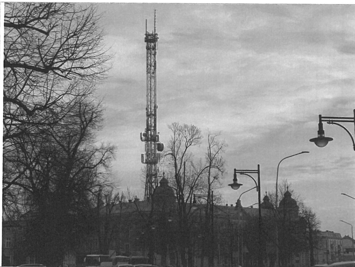
Fot. 1. SLR Legnica / ul. Piastowska – widok wieży antenowej
