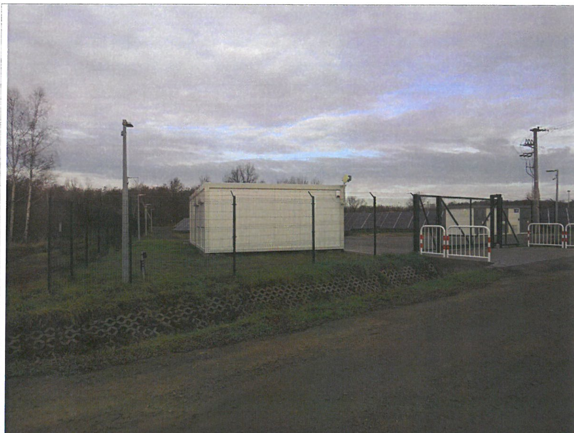
Fot. 1. OM Legnica / ul. Dobrzejowska – widok anteny Emitel na dachu budynku
