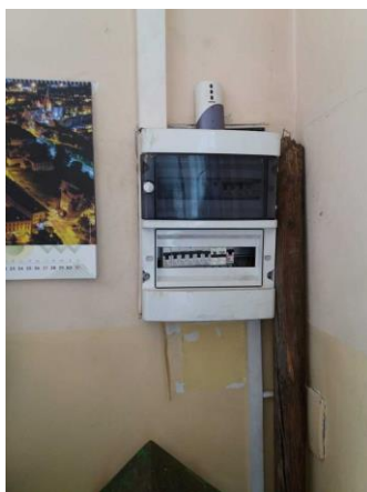
Istniejąca tablica elektryczna w budynku Palmiarni.
