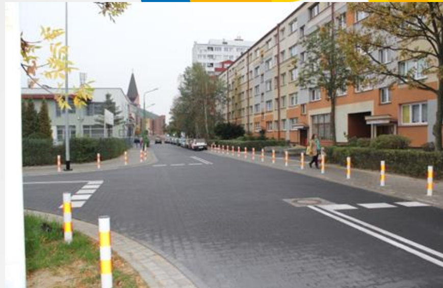
Przebudowa ul. Plutona
