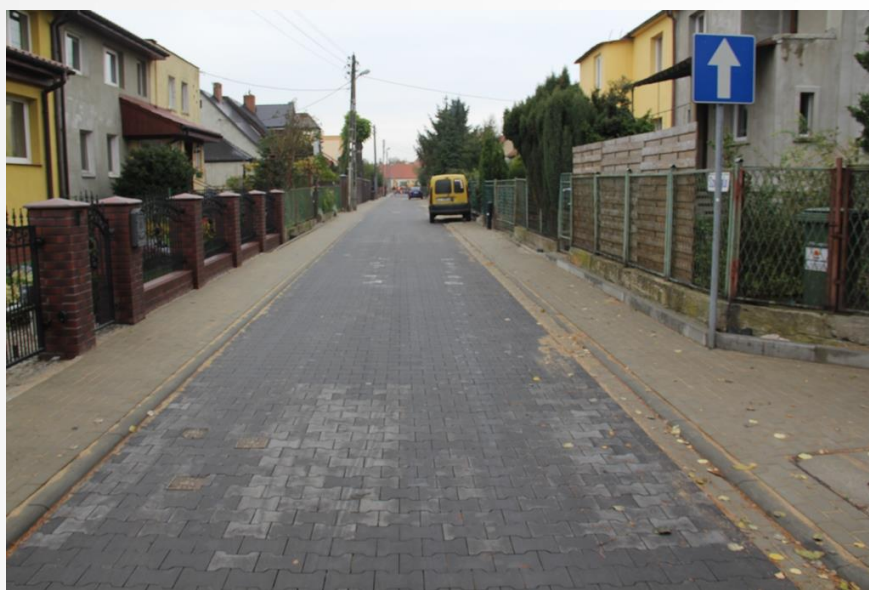
Przebudowa ulicy Szczyglej
