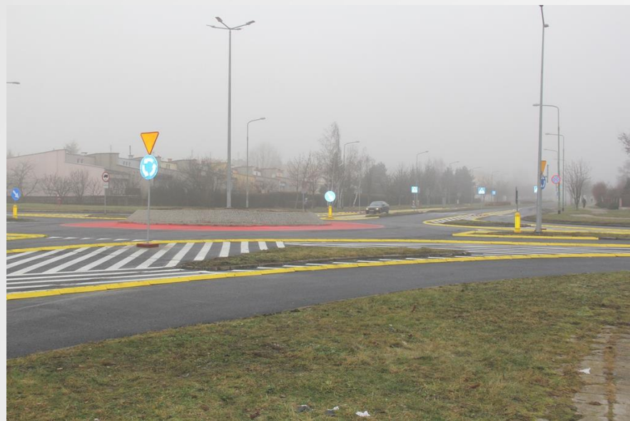
Budowa ronda na skrzyżowaniu ul. Sudeckiej i ul. Sikorskiego
